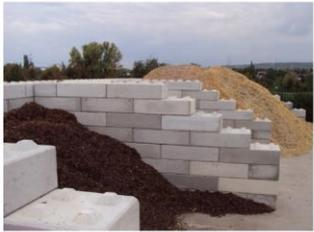
Kees Rijk BV affirme que les murs de soutènement en blocs de béton Legioblock avec fonction de séparation ont une résistance au feu de 240 minutes, basé sur les normes NEN 6069:2011 et EN 13501-2:2016.
